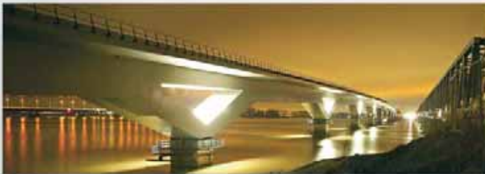
HSL Bridge, Moerdijk/Netherlands
